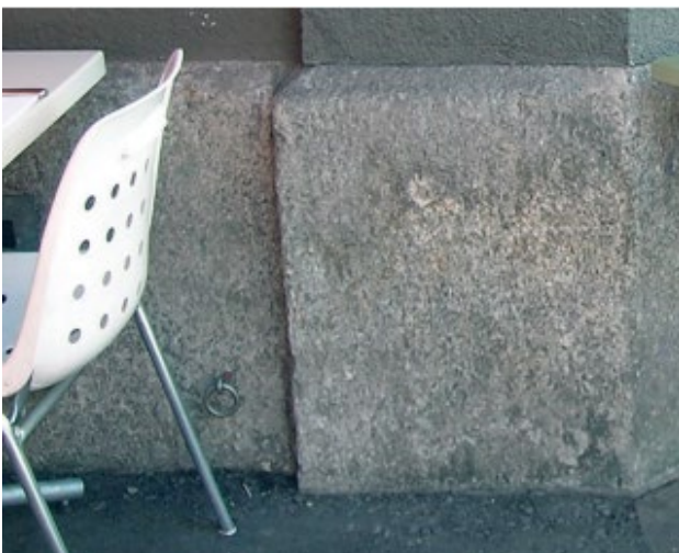
Hohlräume hinter Ziersteinen dienen den Schaben als beliebtes Versteck. Foto: Stadt Zürich, UGZ
